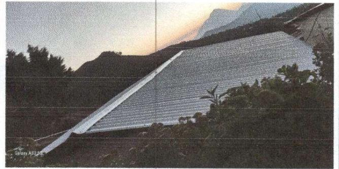
Foto 2: Instalación de lamina troquelada aluzinc calibre 26 módulo 1, aula 2
