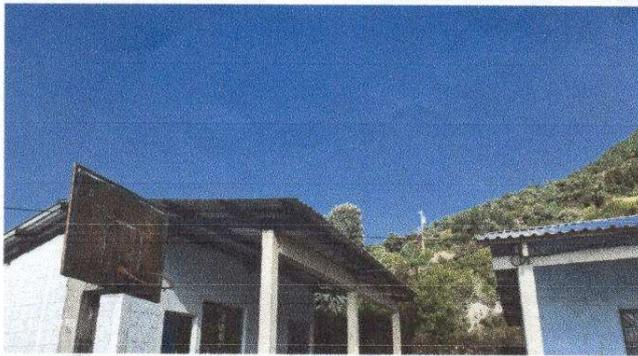
Foto 1: Instalación de lamina troquelada aluzinc calibre 26 módulo 1, aula
